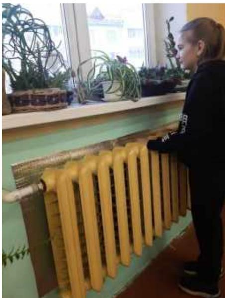
*Фото 7. За батареями установлены теплоотражатели.*
