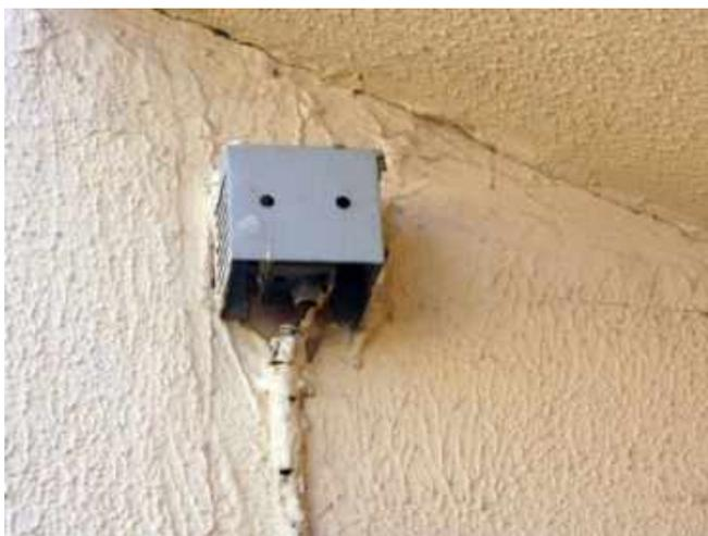
Фото 6. Датчик температуры наружного воздуха.
